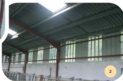
Long-pan arrière bardé de panneaux bétons (2,50 m) et de tôles perforées intercalées avec des tôles pleines (1,30 m).
